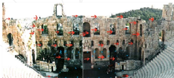
Ηλεκτρακουστική ηχοβελτίωση στο Ηρώδειο με 28 μικρόφωνα (μπλε) και 32 διάσπαρτα ηχεία (κόκκινο).
